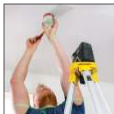
Vedení trubek - od podlahy ke stropu
